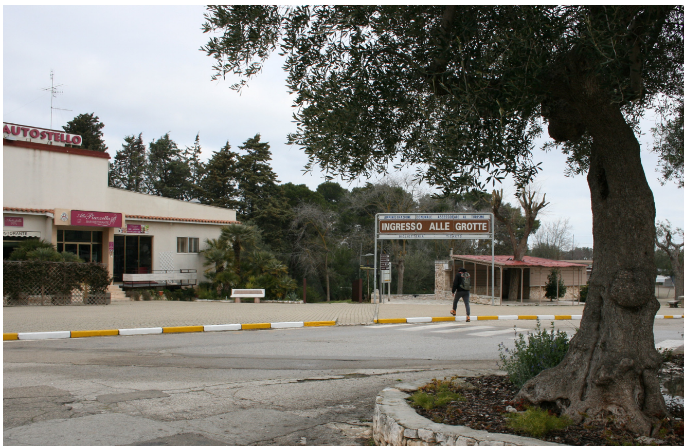
Fig. 4 - La scarsa qualità edilizia e delle sistemazioni esterne che denota l'area di accesso alle Grotte
