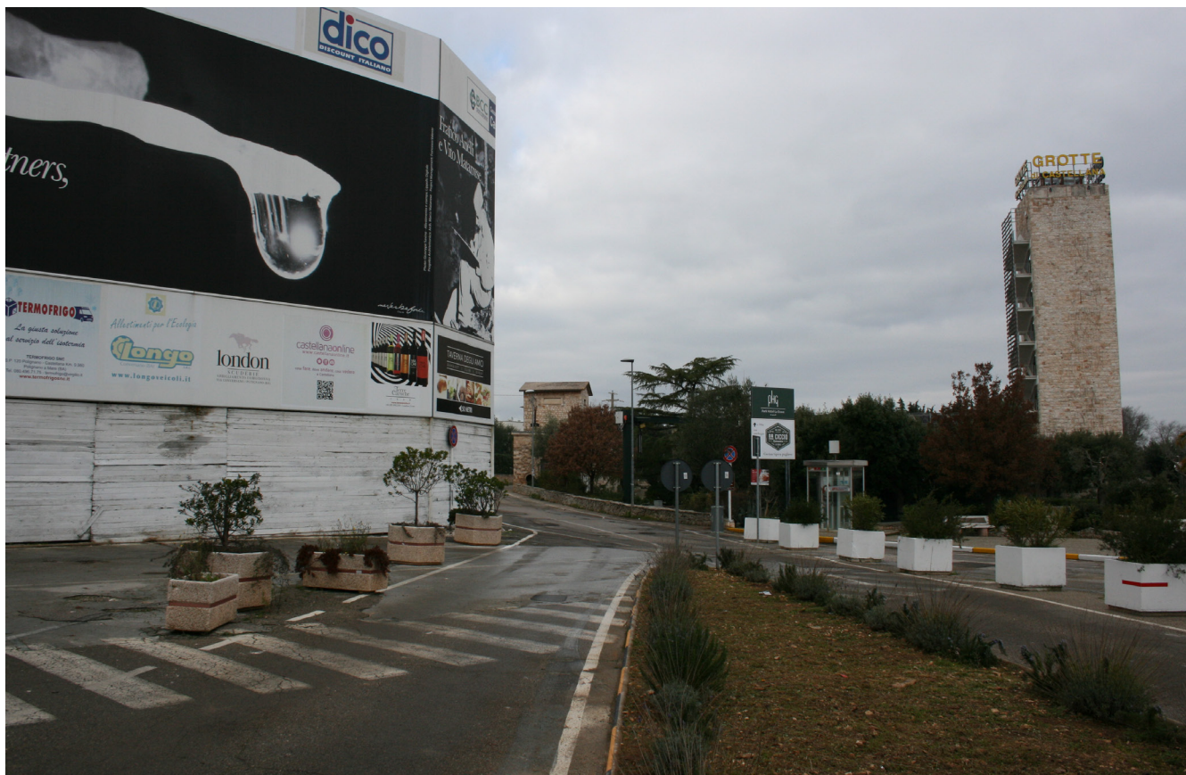
Fig. 15 - L'immobile destinato ad albergo e ormai in disuso e degrado da anni
