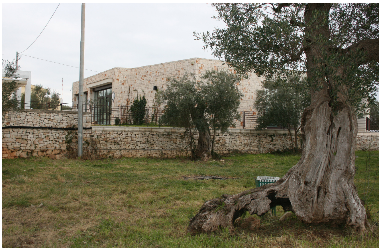
Fig. 17 - L'info-point visto dall'interno del parcheggio
