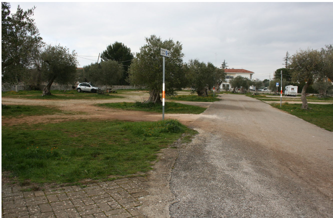
Fig. 23 - La pavimentazione in asfalto che connota l'area a parcheggio
