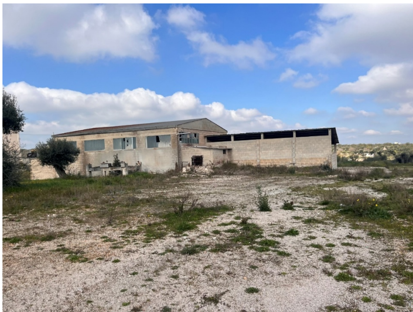
Foto 4 - Vista dell'area di progetto fronte Ovest
