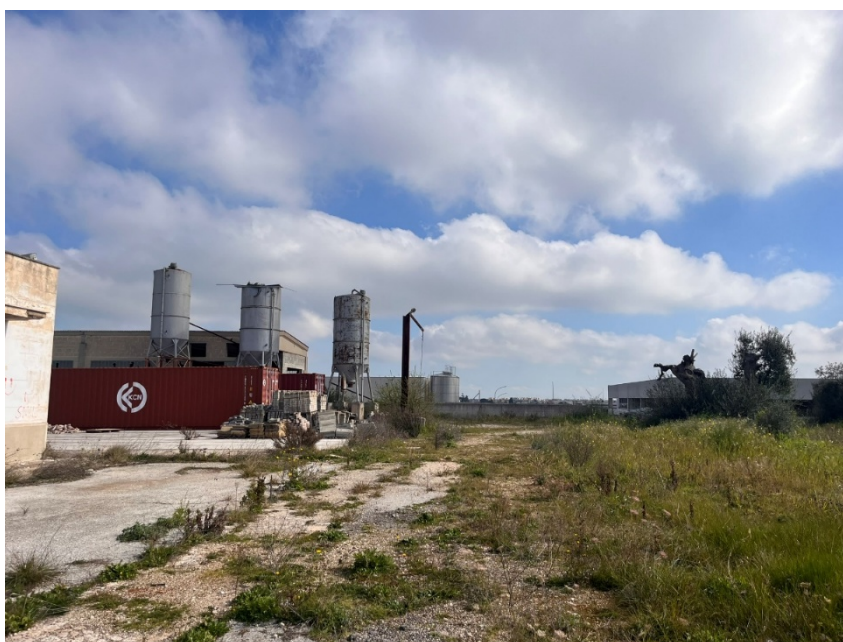
Foto 1 - Vista dell'area di progetto fronte Ovest
