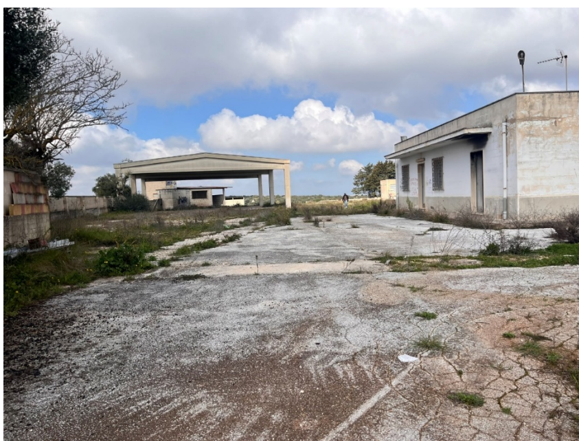
Foto 3 - Vista dell'area di progetto fronte Ovest
