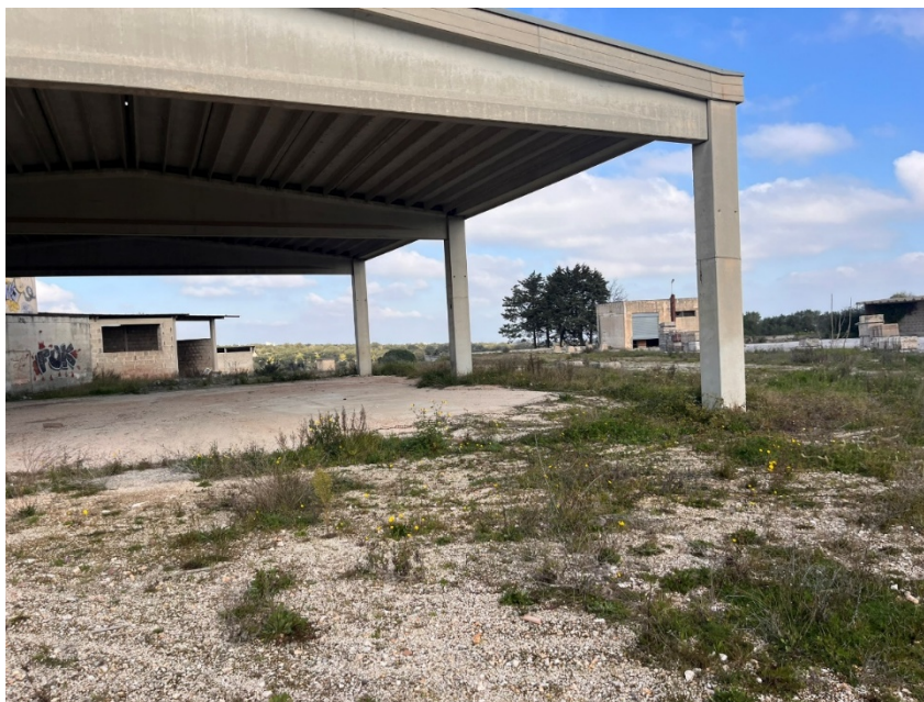
Foto 1 - Vista dell'area di progetto fronte Ovest
